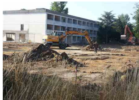
Les travaux de démolition des locaux de l'ancienne clinique des Cèdres touchent à leur fin. Le bâtiment encore debout
